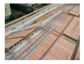
Man schätzt die hervorragenden Eigenschaften der Ziegeldecke und verwendet diese nun auch in den Dachschrägen.
